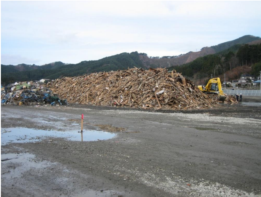
荒選別後 木くず (大槌町2次仮置場)
