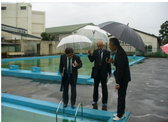
プールの管理状況確認（清水三保第一小学校）
