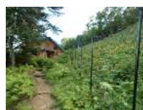
防鹿柵の設置状況
