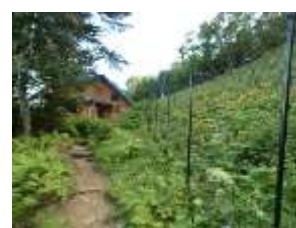
防鹿柵の設置状況
