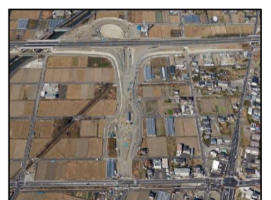
▲工事状況 平成 31 年 1 月撮影
