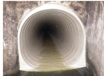
写真 3：耐震補強完了後
