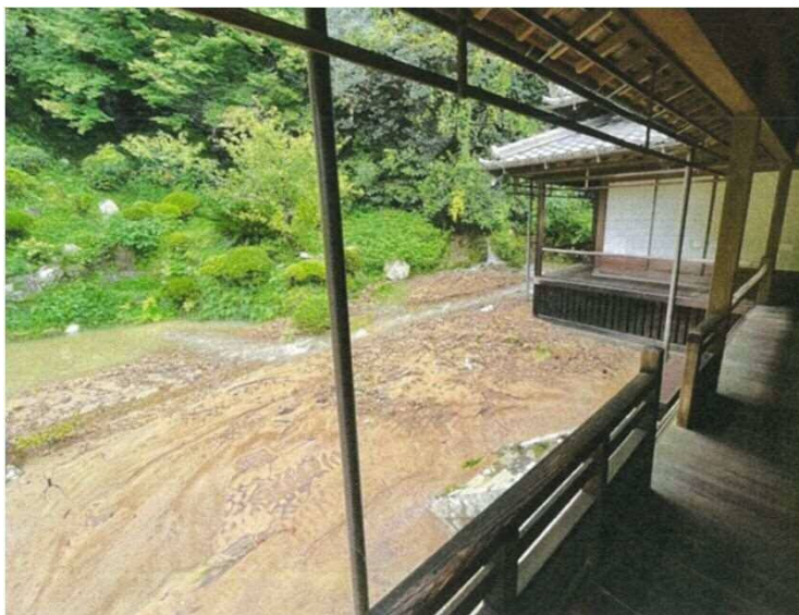
清見寺庭園への土砂流入の様子
