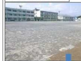
雨水貯留浸透施設
