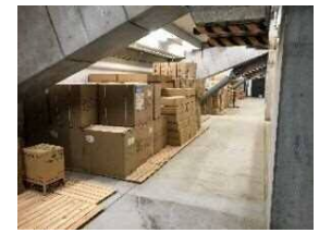
吹田スタジアムの備蓄倉庫 (観客席スタンド下に設置)
