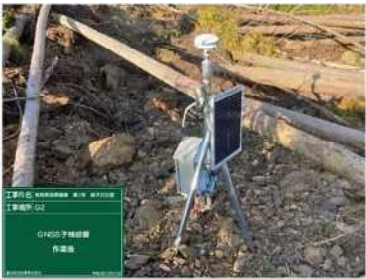
GNSS子機G-2 (23/10/27設置)
