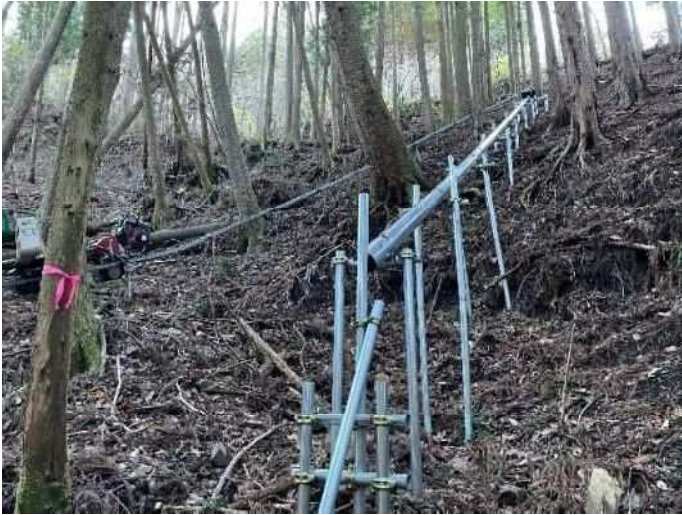
写真4. 3 S-3 設置状況
