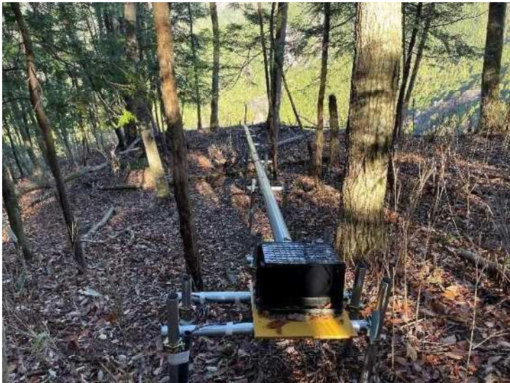
写真 4. 2 S - 2 設置状況
