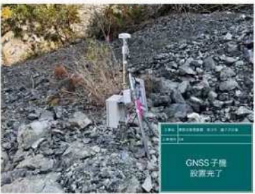
GNSS子機G-4 (23/10/27設置)
