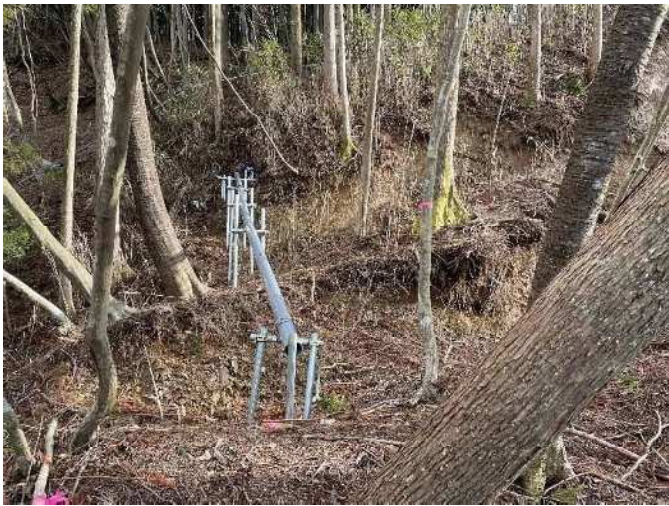
写真4. 1 S-1設置状況
