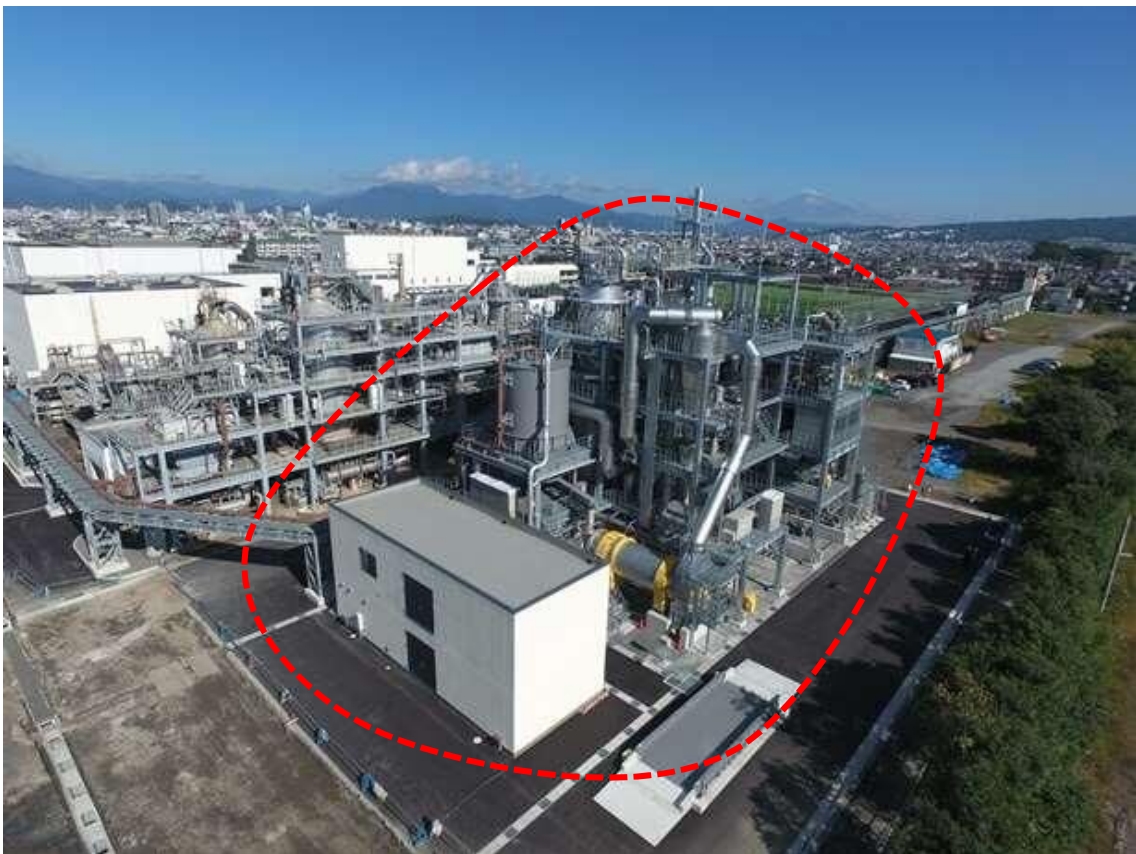
中島浄化センター汚泥燃料化施設
