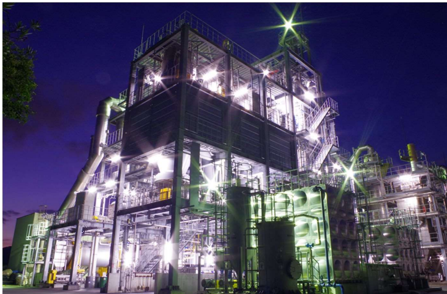
中島浄化センター污泥燃料化施設
