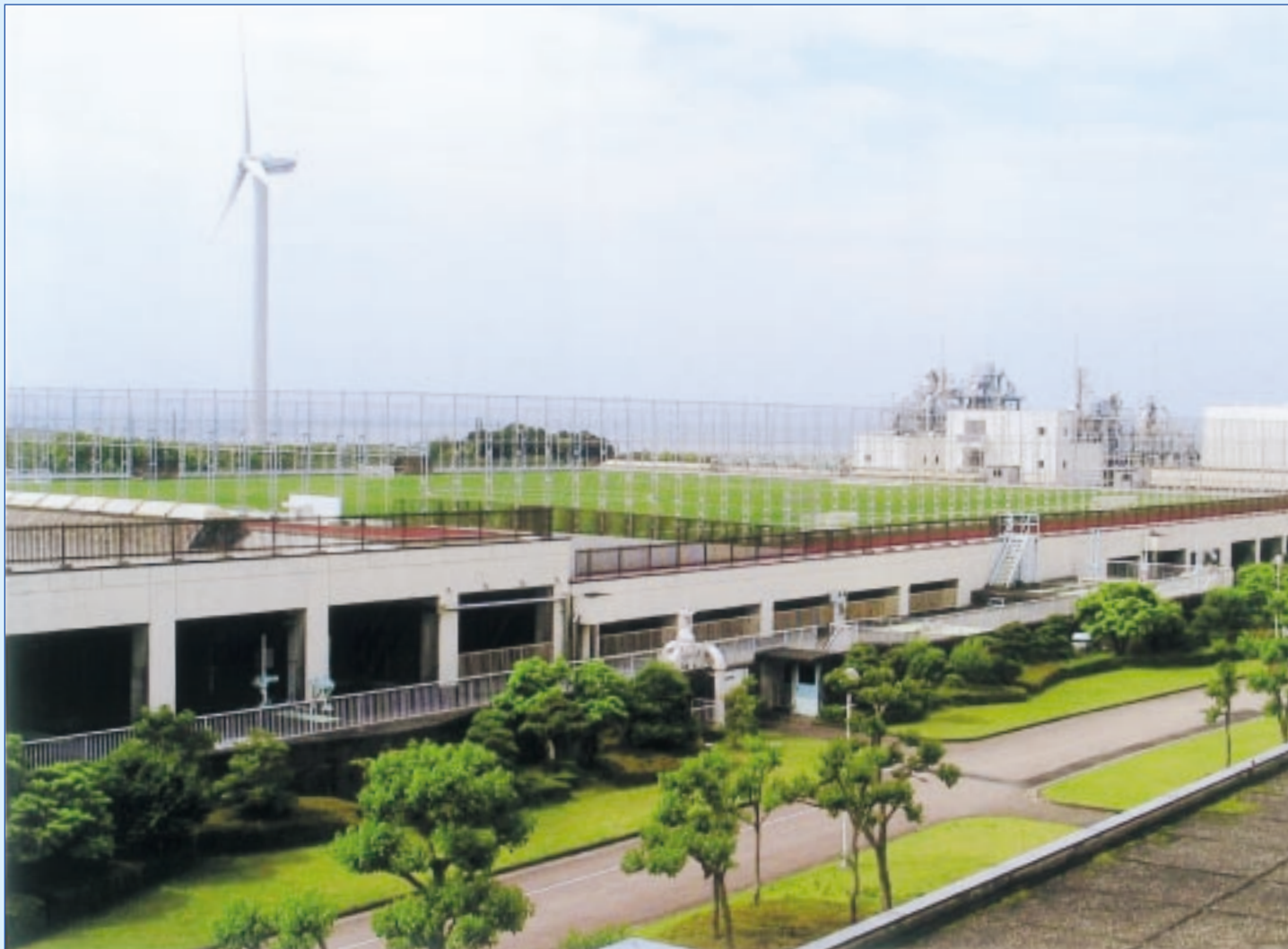
中島浄化センター（水処理施設上部に平成16年5月完成した「人工芝多目的スポーツグラウンド」と、敷地南西側に平成16年3月完成した「風力発電施設（愛称：風電君）」）
