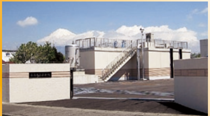
蒲原第3浄水場は、富士川右岸の3つの井戸から汲み上げた水を滅菌し城山配水池へ送る施設です。施設の耐震化及び安全な水を安定して供給するための改修事業が平成21年2月に完成しました。
