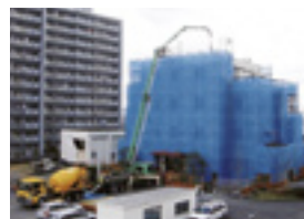
南安倍取水場耐震化工事(H20)
