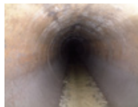
耐震化前の下水道管
