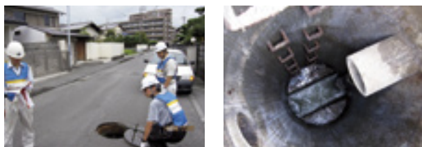
地震後の下水道管の調査状況(H21.8.12)
