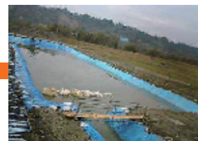
仮設沈殿地の設置状況
