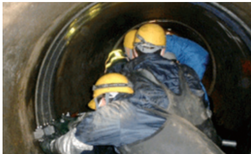
管路継目部への耐震継手設置状況
