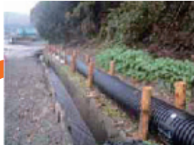
仮設配管の設置状況
