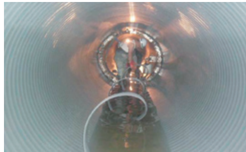
更生工法（更生材の巻き立て状況）
