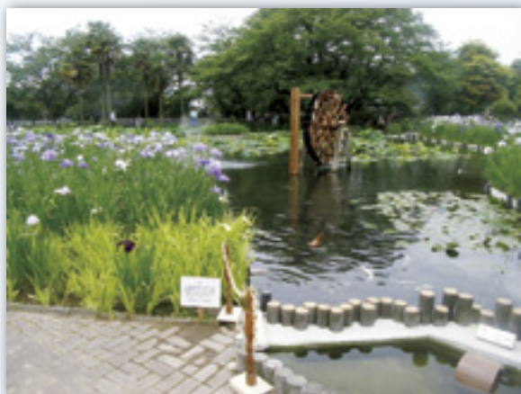
城北浄化センター 遊水池
