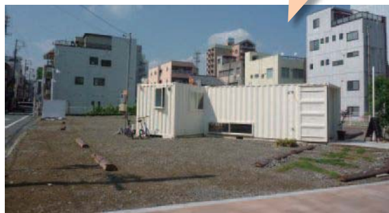
上下水道局庁舎建設予定地（葵区七間町）
