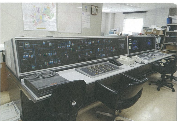
監理室：配水池から出ていく水の量を把握し、取水場の機械を動かしているところです。
