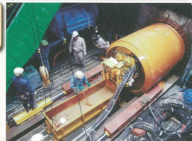
下水道工事風景
