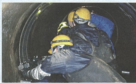
下水道管の耐震継手設置状況
