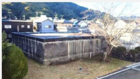
(写真1: 既設配水池)
