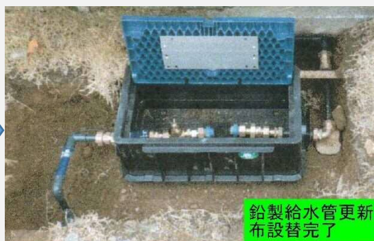
(写真1:鉛製給水管更新修繕)
