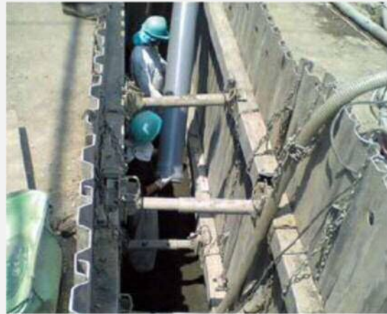
(写真2:下水道管布設) 決められた深さに管を設置します
