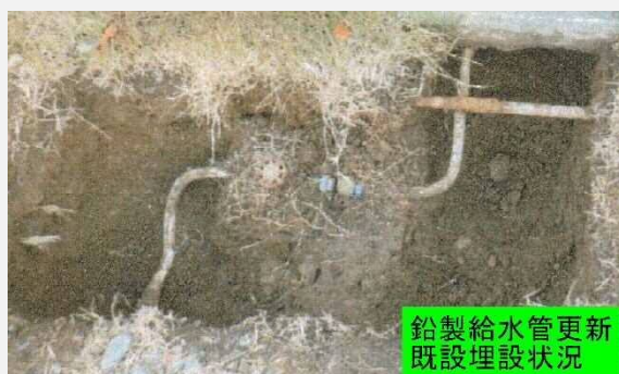
(写真1:鉛製給水管更新修繕)
