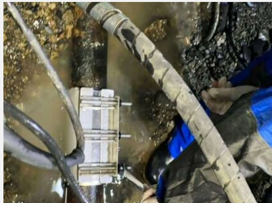
(写真5: 修繕後の様子)
