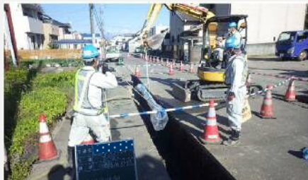
(写真3: 水道管更新工事施工状況)
