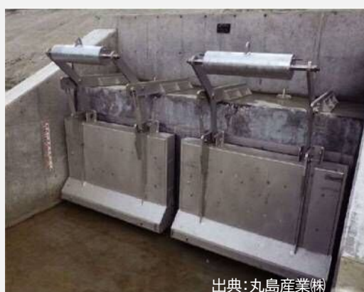
(写真2:フラップゲート*)
