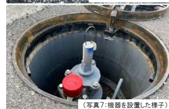
(写真7: 機器を設置した様子)
