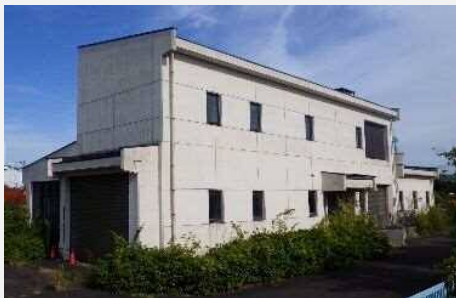
(写真1:宮加三ポンプ(廃止予定))
