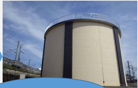
(写真3:新しい配水池)
