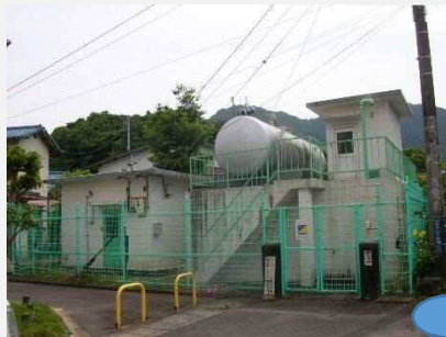
(写真2:小規模な加圧施設)
