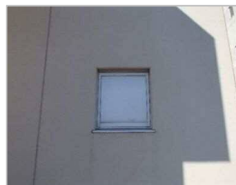
(写真5:窓の閉塞)
