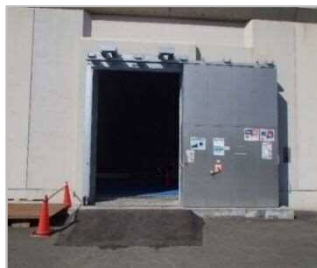
(写真4:防水扉の設置)
