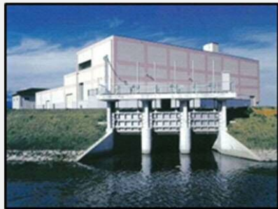
(写真2:雨水ポンプ場*)
