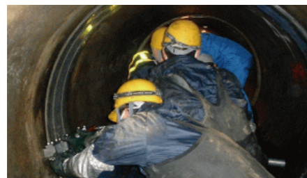
【下水道管の耐震継手設置状況】
