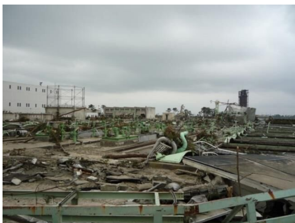
津波による浄化センターの被害状況
