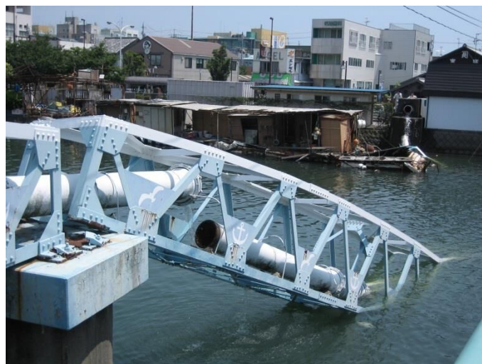
図 3-6 老朽化し破損した水道管
