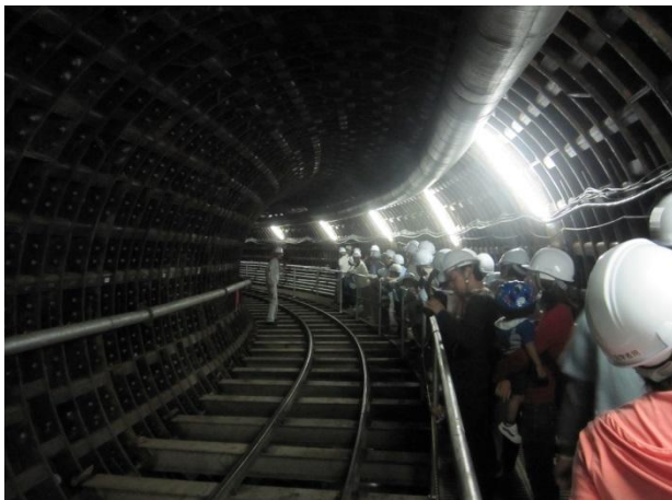
図2-6 下川原雨水貯留管工事(見学会)の様子
