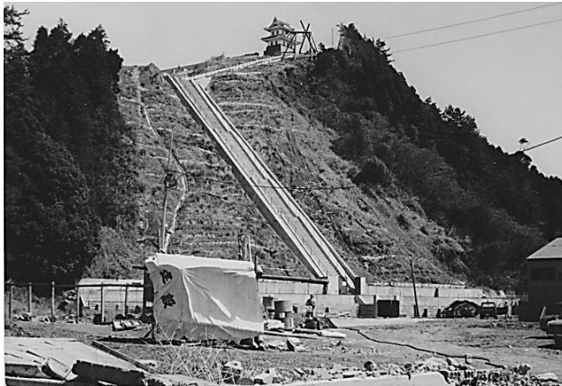
図 2-2 大平山配水池築造工事風景(1967年(昭和42年)頃)
