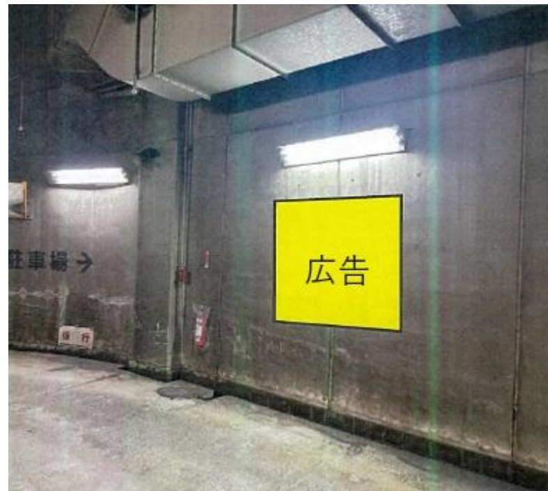
(静岡庁舎新館地下1階来庁者用駐車場壁面)
