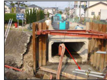
雨水渠の整備
