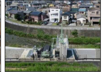
雨水ポンプ施設の整備
