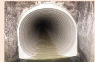
内面を補強した後の下水道管
