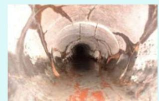
ひび割れが生じている下水道管
