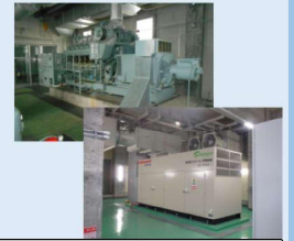
清水谷津浄水場 非常用発電機の更新 上:更新前、下:更新後
