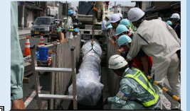
老朽管の更新
