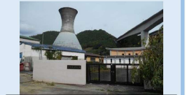
和田島浄水場
