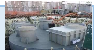
従来の耐震性貯水槽(埋設中)
