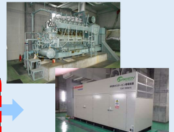
清水谷津浄水場 非常用自家発電設備の更新 上：更新前 下：更新後
