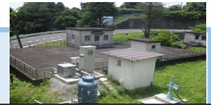
蒲原城山配水池
