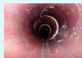
改築工事实施前の 下水道管
