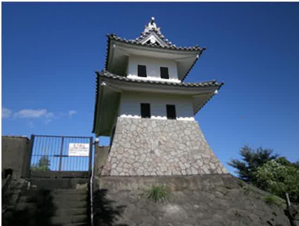
大平山配水池
