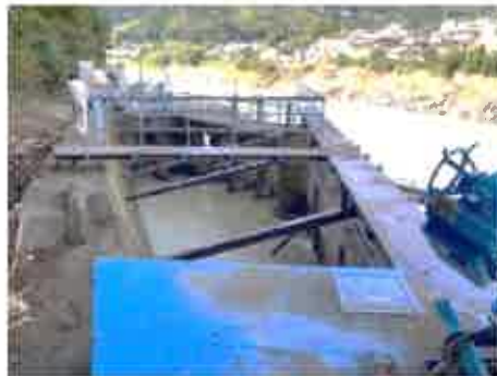
手摺・フェンス・水位計 流失
