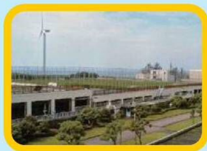
なかじまじょうか 中島浄化センター (中島処理区)
