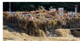
台風15号直後の承元寺取水口
