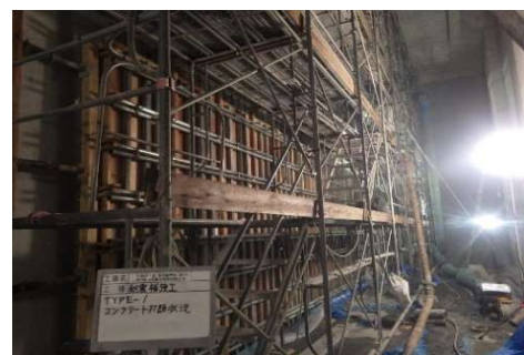
※耐震補強工事中の配水池内部
