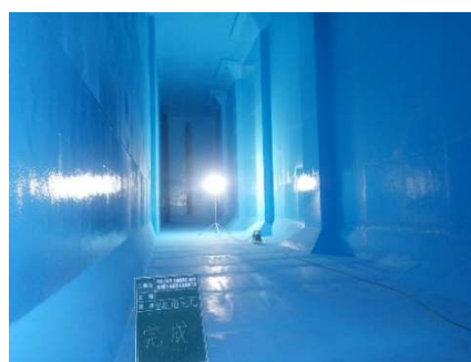
※耐震補強工事後の配水池内部
