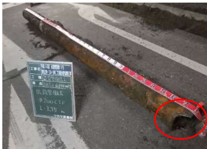
※老朽化した水道管の撤去状況
