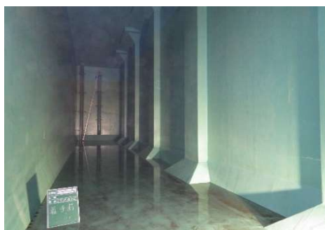
※耐震補強工事前の配水池内部
