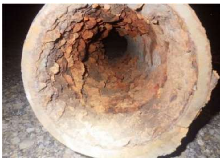
※撤去した老朽管の内部状況（口径 200 mm）
