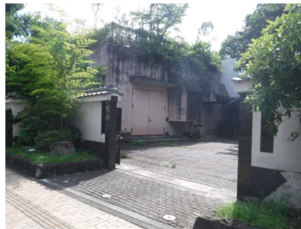
※配水池の外観
