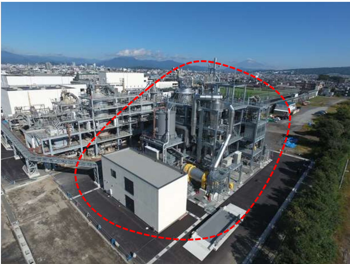
中島浄化センター汚泥燃料化施設
