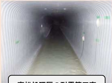
高松処理区の耐震管工事
