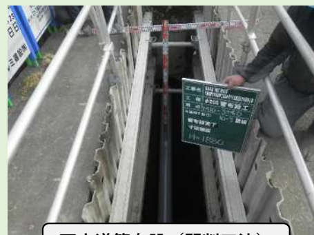
下水道管布設（開削工法）
