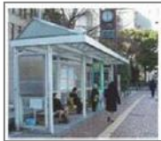
▲上屋設置状況
