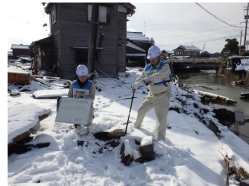
【調査状況（珠洲市）】
