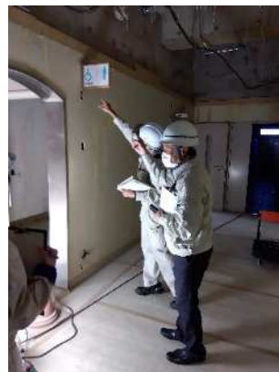
設備工事（衛生）
