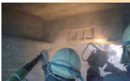
モルタル拭き付けによる断面修復
