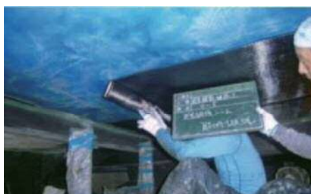
炭素繊維シートの貼り付け
