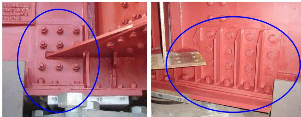
写真-5.2.3 あて板補強の実施例
