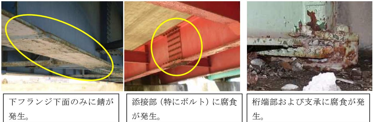
写真-5.2.1 局所的な塗膜劣化の発生例
