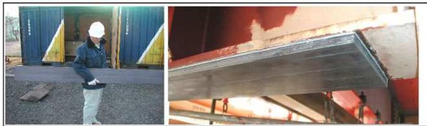
図-7.2.2 連続繊維板接着工法の例
