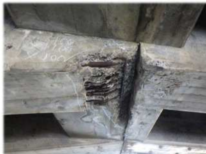
写真 2.1 高齡橋の老朽化事例
