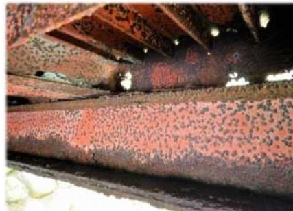
写真 2.1 高齡橋の老朽化事例
