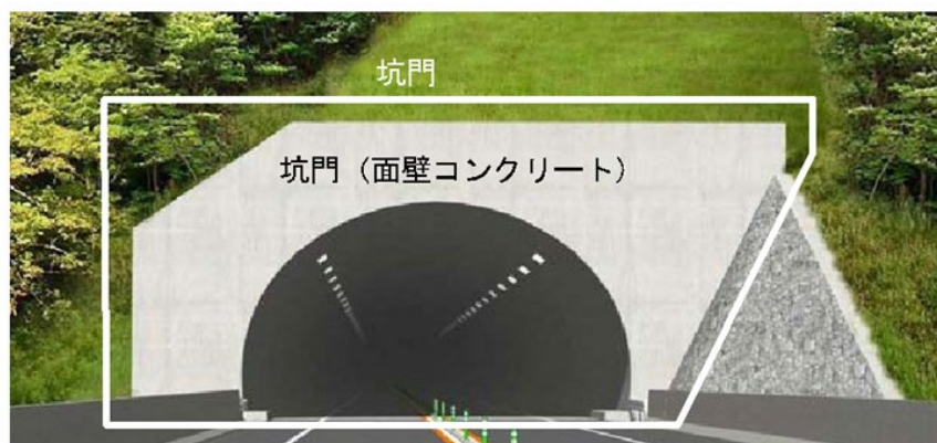
図 1-2 点検対象箇所(トンネル坑口部)
