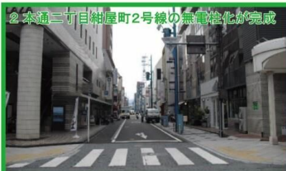
2 本通二丁目紺屋町2号線の無電柱化が完成 沿線に飲食店や商業施設、宿泊施設が建ち並ぶ歩行者が多い道路ですが、電柱が歩行空間を圧迫し、通勤・通学時には歩行者が車道部に溢れ出す危険な状態でした。電線を地中化することで歩行空間を創出し安全を確保することができました。
