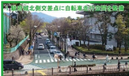
1 駿府城北側交差点に自転車走行空間を整備 通勤・通学時間帯に歩行者・自転車・自動車と交錯していた駿府城公園北側交差点の自転車利用環境が向上しました。さらに、交通管理者、教育委員会、学校関係者と連携し、通行ルール・マナーの啓発活動を行い、より安全な交差点となりました。
