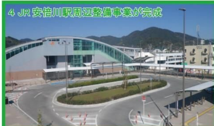
4 JR 安倍川駅周辺整備事業が完成 新駅舎・自由通路の整備による駅のバリアフリー化と、駅前広場やアクセス道路の整備による交通結節機能の強化により、地域拠点として発展する安倍川駅周辺地区の更なる利便性・安全性の向上につながりました。
