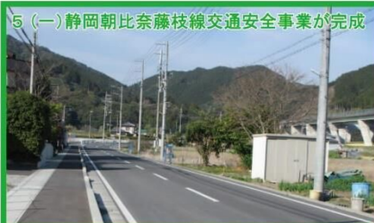
5 (一) 静岡朝比奈藤枝線交通安全事業が完成 新東名静岡SASスマートICと国道362号や県道奈良間手越線を結ぶアクセス道路であり、緊急輸送路に指定された路線で、スマートICの開設に伴い交通量が増大しました。歩道整備により歩行者の安全を確保でき交通事故軽減が図られます。
