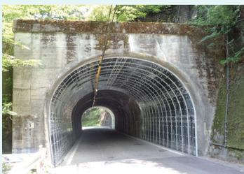
南アルプスユネスコエコパークへ繋がる(主)南アルプス公園線のトンネルについて、過去の点検で対策が必要とされた損傷などの補修工事を実施することにより、構造物の健全性を向上させ、通行の安全を確保しました。
