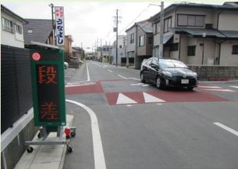
幹線道路に囲まれ、渋滞回避の車両が生活道路を抜け道に利用し交差点事故が多発する入江地区に、県内で初めて速度抑制に効果的な交差点ハンパを設置し、通過交通の侵入抑制により、歩行者・自転車が安心・安全に利用できるようになりました。
