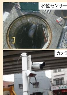
冠水の恐れのある16箇所のアンダーパスに、冠水状況を監視する水位センサーとカメラを整備し、監視センサーで情報を一元管理できるようになりました。現場状況をリアルタイムで把握し、冠水による事故を未然に防ぐ措置をいち早く講じることができます。
