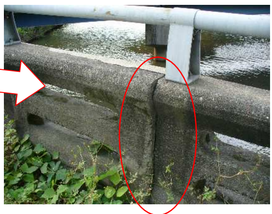
中間支点の掛け違い桁で平面的なずれが生じている例
