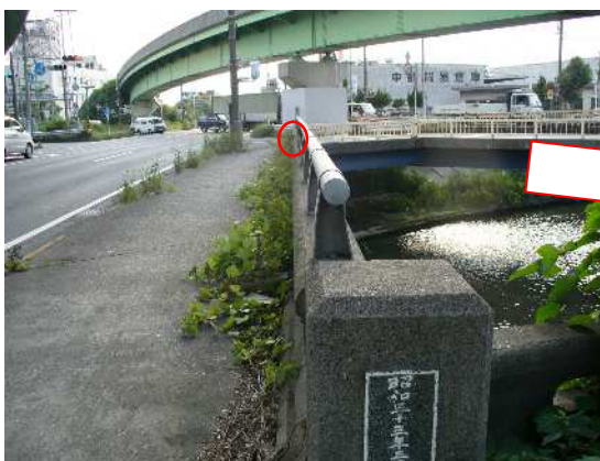
中間支点の掛け違い桁で平面的なずれが生じている例
