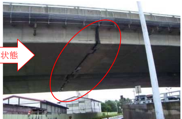
P C橋の中央ヒンジ部が垂れ下がっている状態
