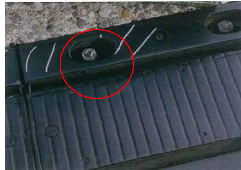
伸縮装置のボルトの緩みにより、異常な音が発生した例
