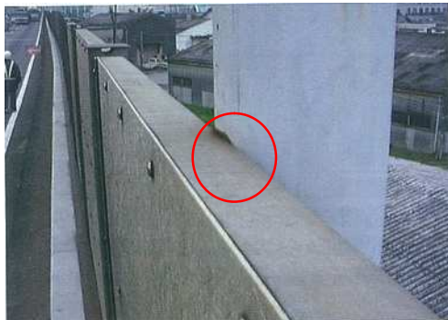
遮音壁と照明柱が干渉して、異常な音が生じた例
