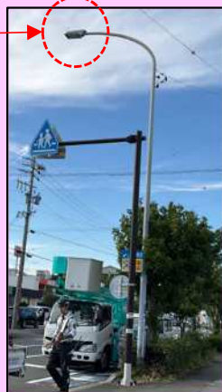
LED化施工後
