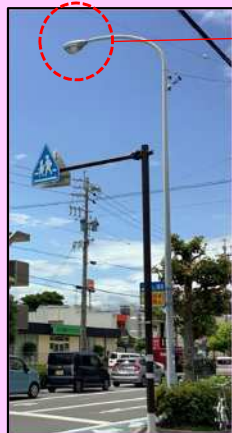
LED化施工前
