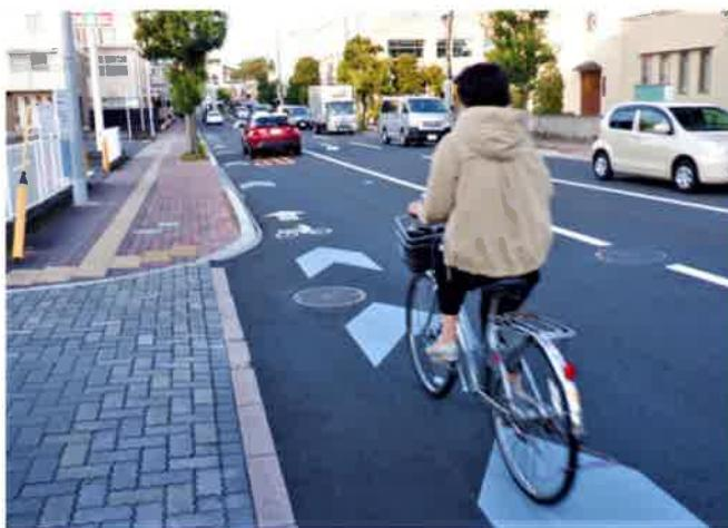
写真9　車道混在（矢羽根型路面表示）
