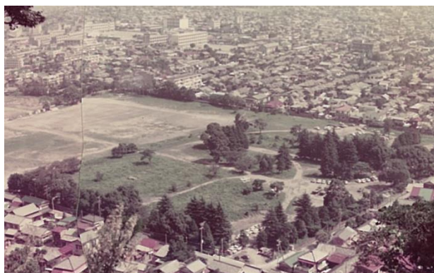
静岡大学解体後の状況
