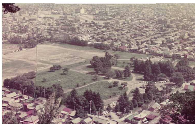
静岡大学解体後の状況
